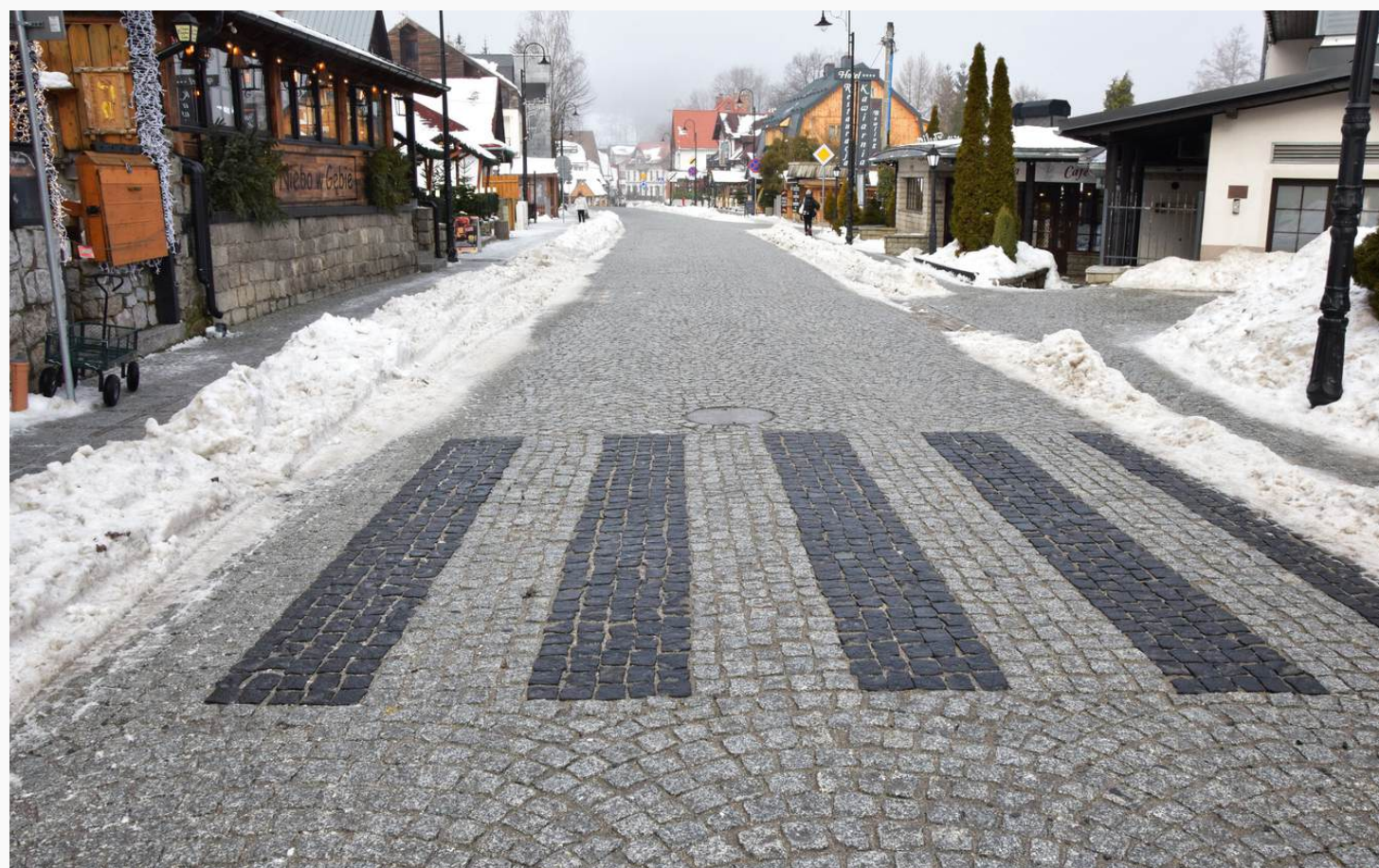
Przebudowa ul. 1-go Maja w Szklarskiej Porębie
