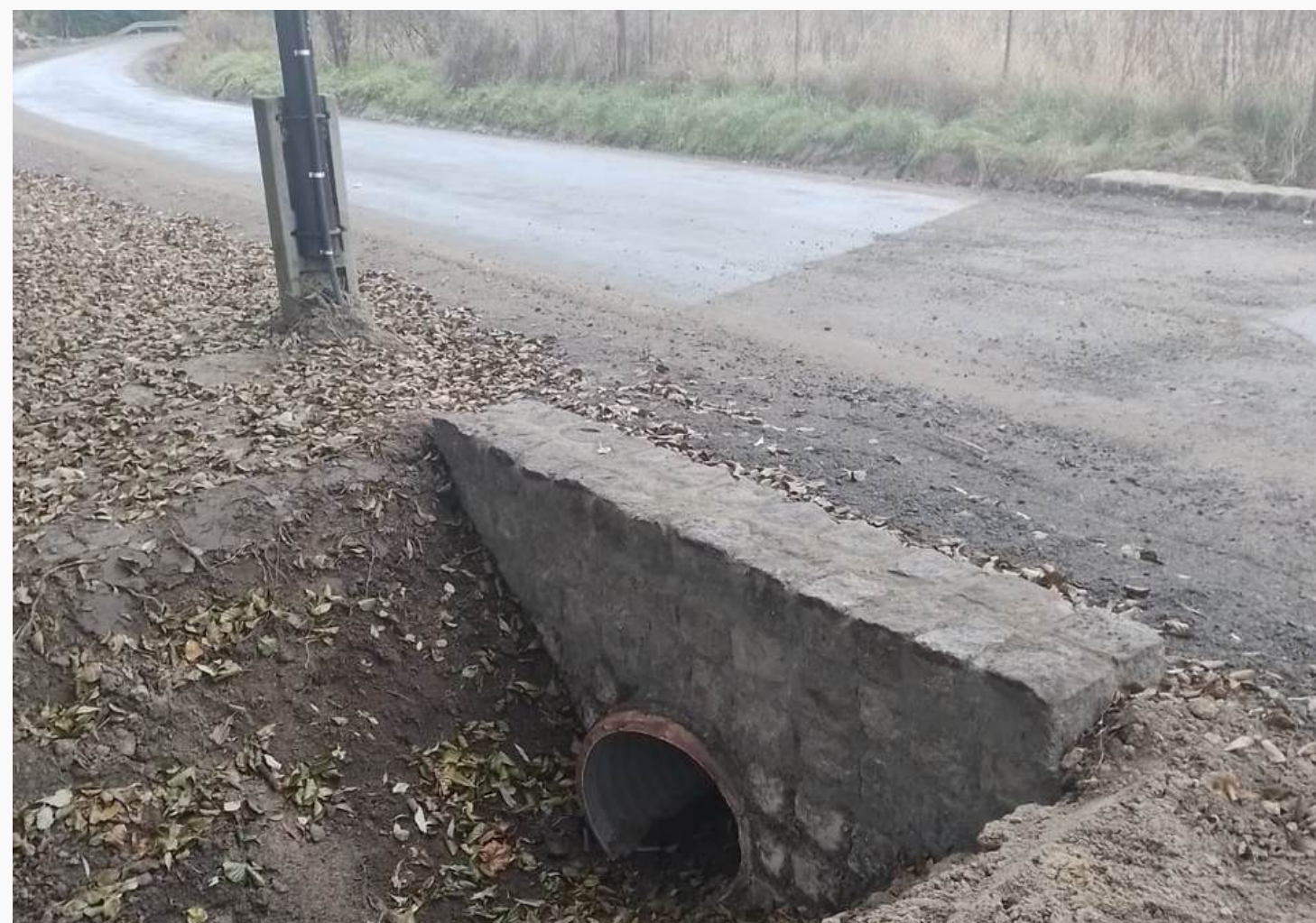
Remont drogi powiatowej nr 2521D Czernica
