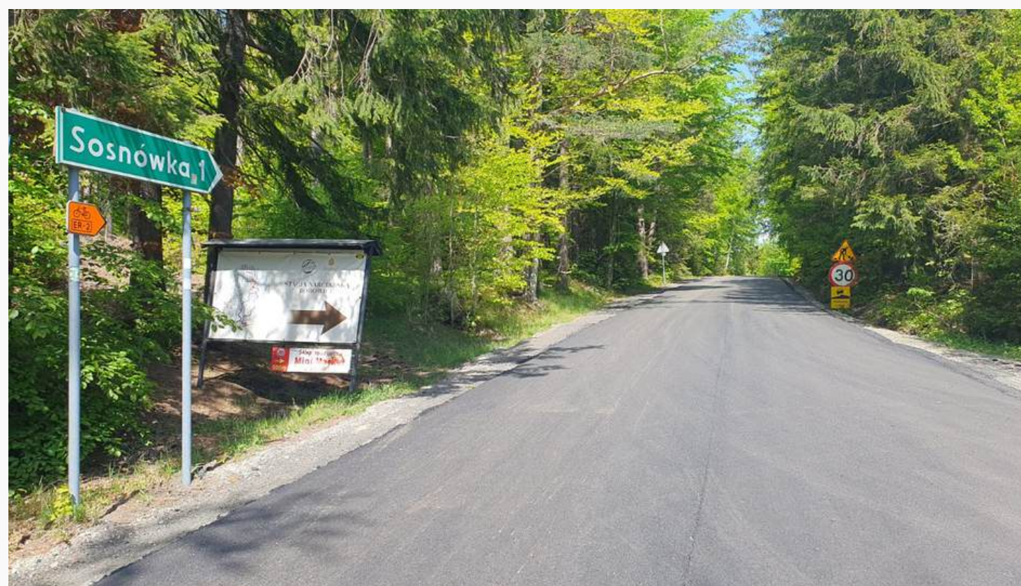
Przebudowa drogi powiatowej nr 2720D Podgórzyn–Borowice–Sosnówka
