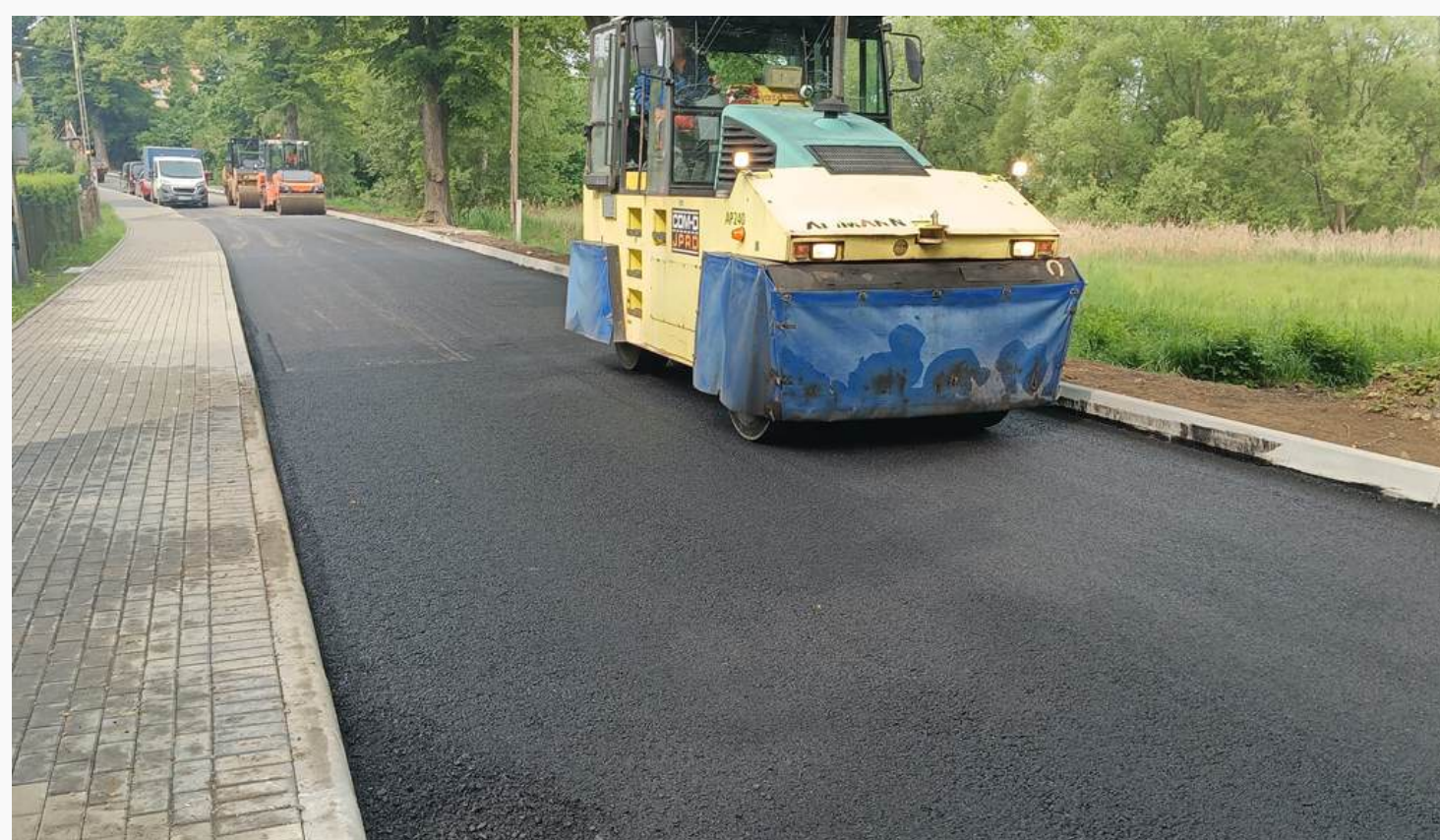
Modernizacja drogi powiatowej nr 2735D w Janowicach Wielkich
