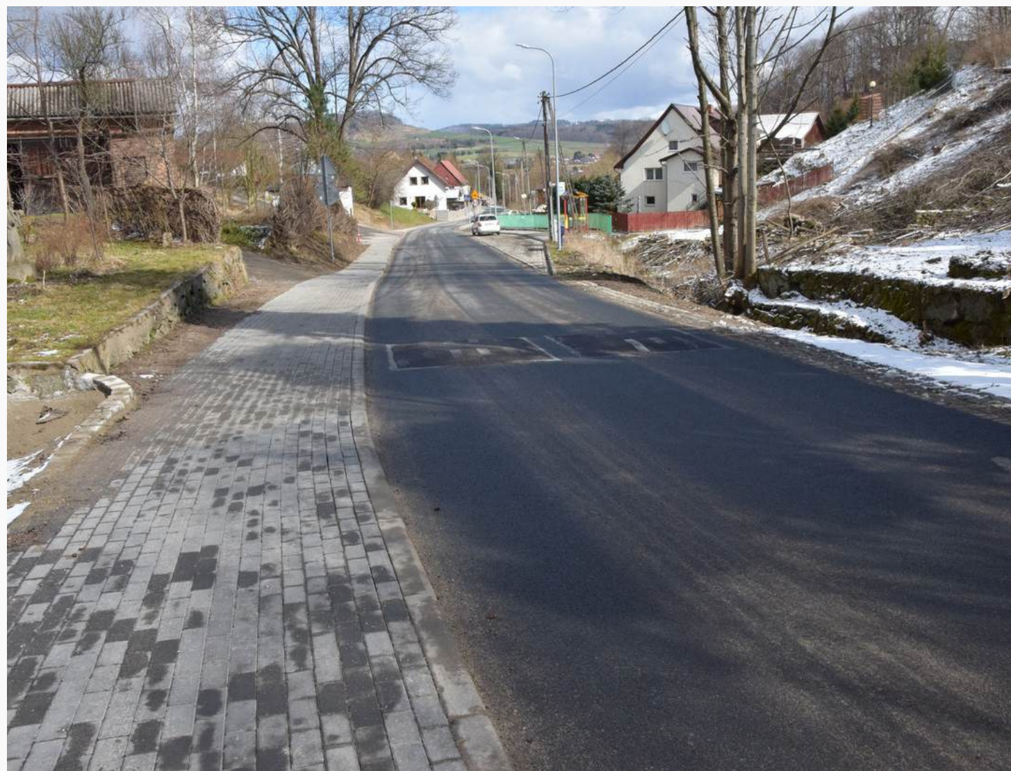
Przebudowa wraz z elementami rozbudowy ul. Górnej w Siedlęcinie
