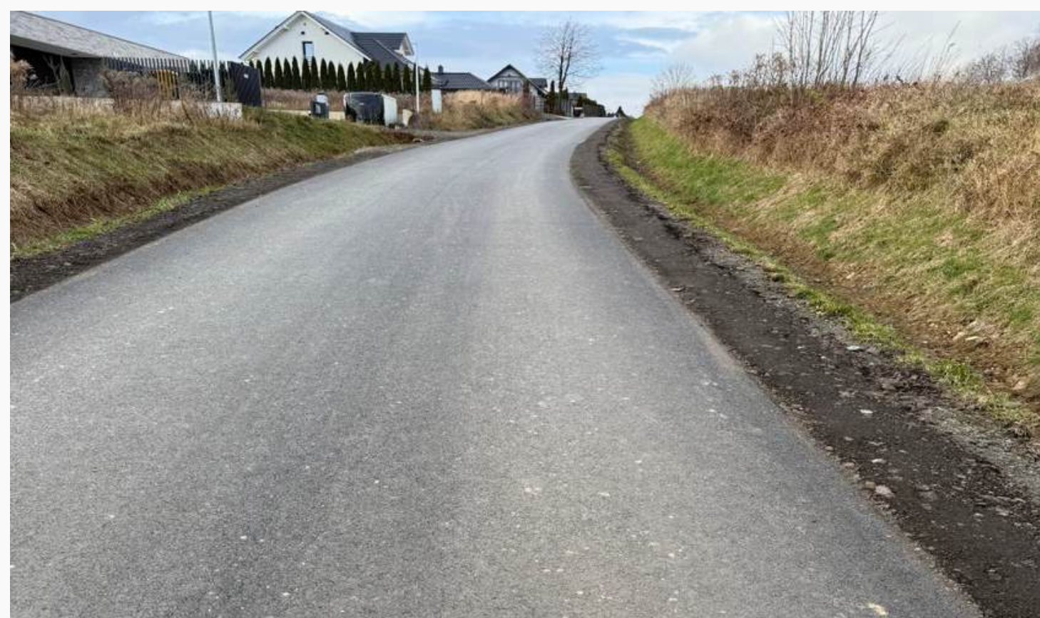
Remont drogi powiatowej nr 2729D Płoszczyna – Dziwiszów
