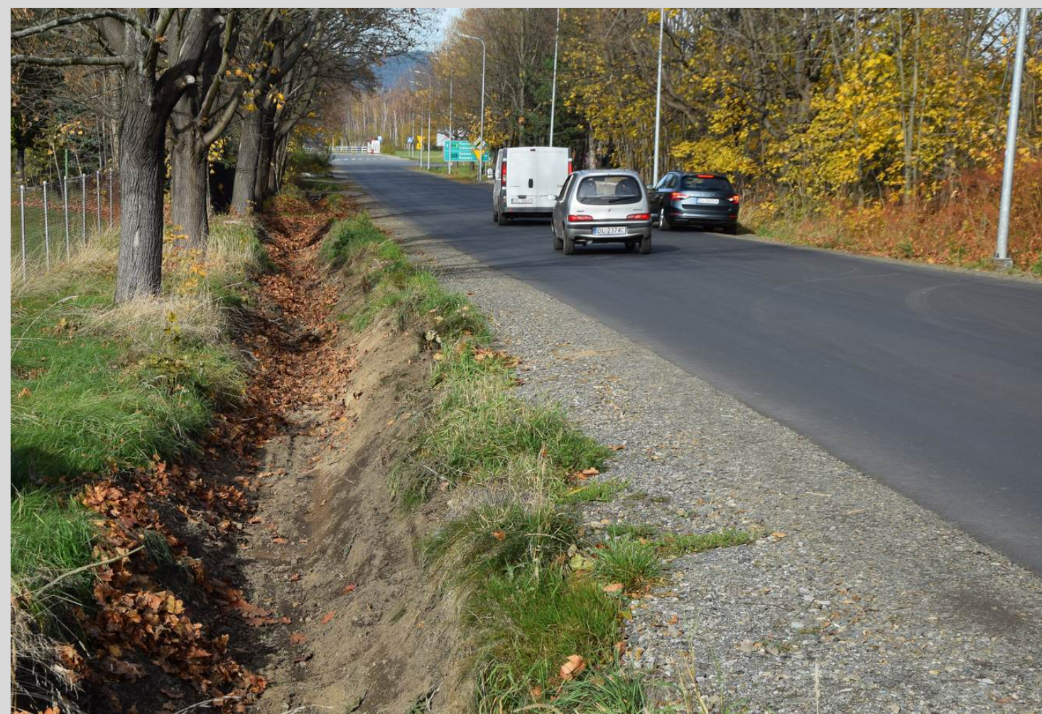
Remont drogi powiatowej nr 2721D w miejscowościach: Podgórzyn-Przesieka
