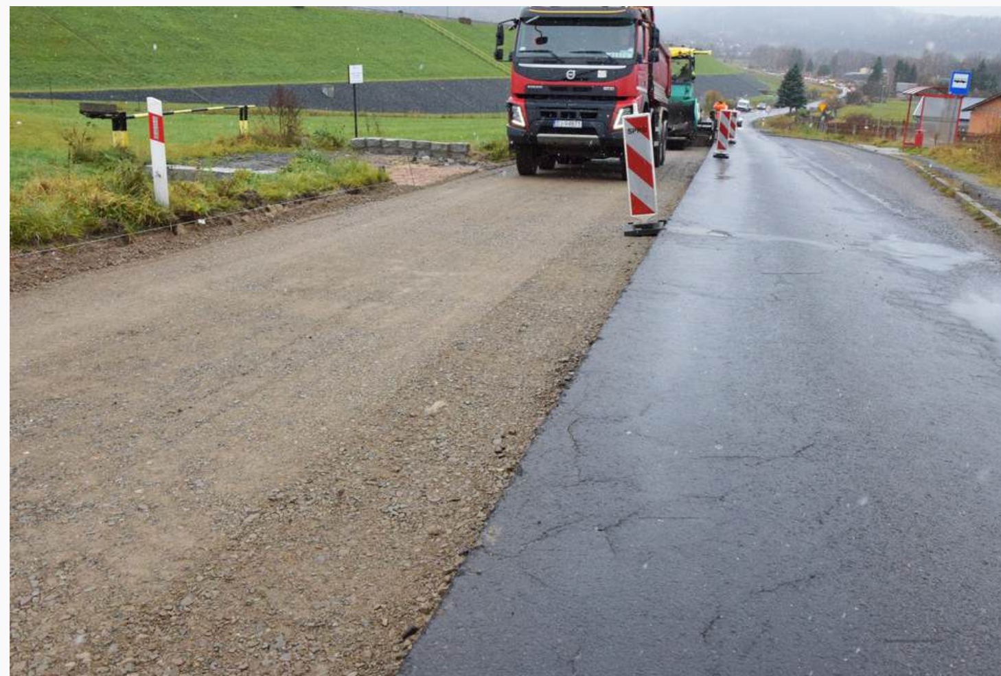
Remont drogi powiatowej (dawna DW 366)
