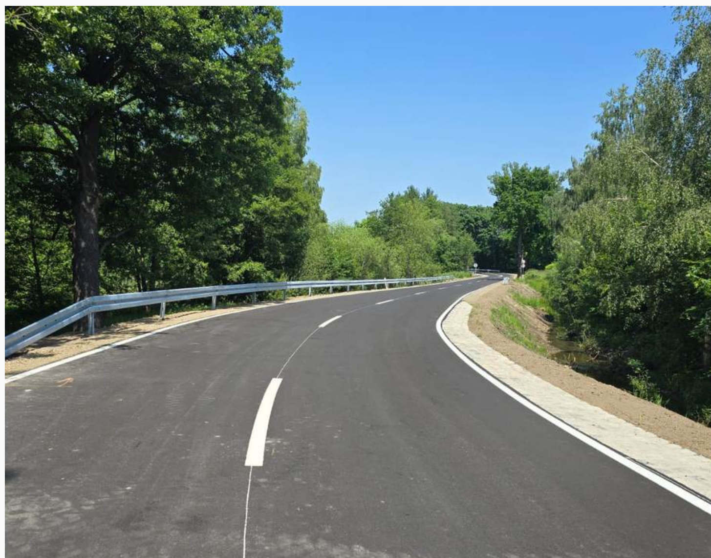
Modernizacja infrastruktury drogowej drogi powiatowej nr 2650D w Podgórzynie
