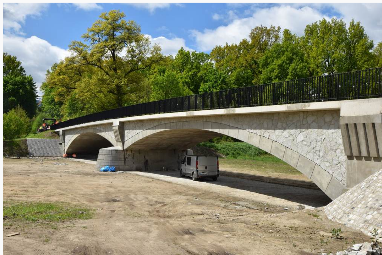
Remont mostu w ciągu drogi powiatowej nr 2742D w Mysłakowicach
